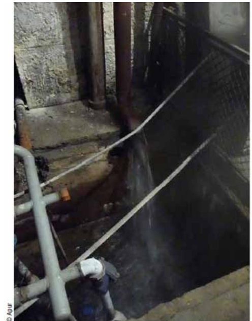
Exemple d'une sous-station mal entretenue, renvoyant les condensats directement à l'égout
